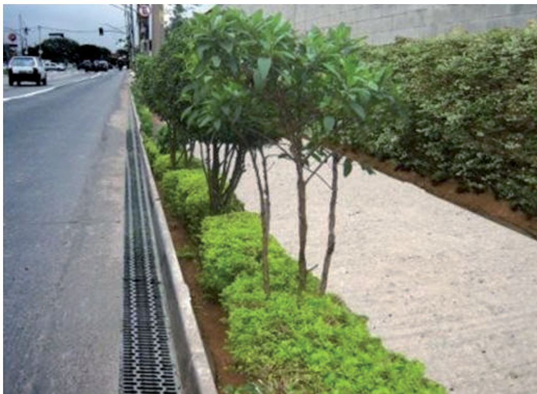
Figura 16 - Exemplo do que seria a combinação de valetas drenantes e calçadas ajardinadas.
