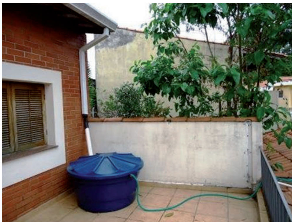
Figura 13 - Uma outra instalação para acumulação e uso de águas de chuva incidentes sobre telhados.
